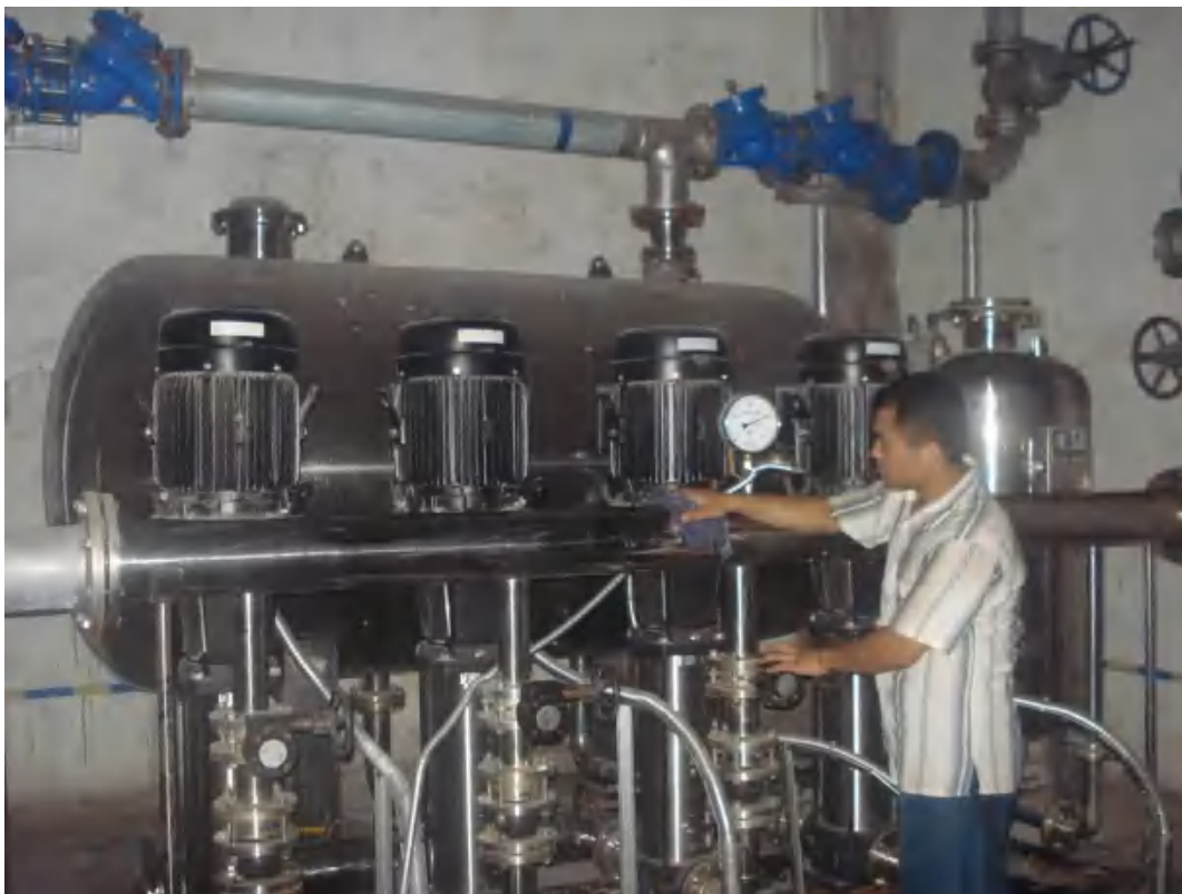
ZWL-现场定期巡检图
